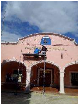
Edificio de Presidencia Municipal
